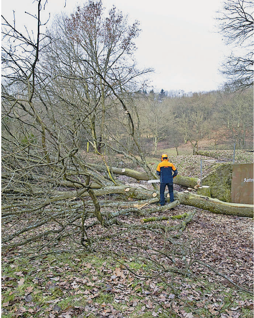
Rodungsarbeiten leiten den Bau der Besseringer Ortsumgehung ein. Die eigentlichen Straßenbauarbeiten beginnen im Oktober. Foto: rup
